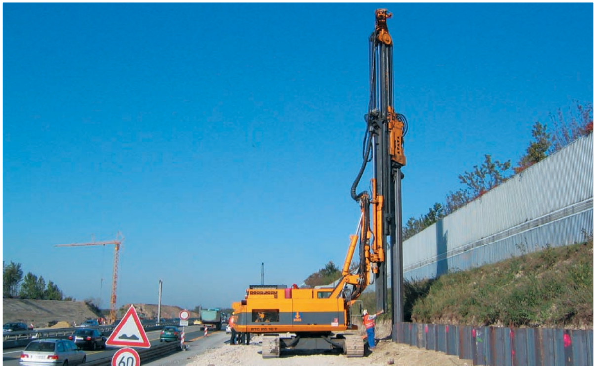
Spundwandeinbau mit RG 16T und Rüttler MR 100V-02 (oben in Garching, unten in Australien) Installation of sheet piles with RG 16T and vibrator MR 100V-02 (top: Garching, Germany, bottom: Australia)
