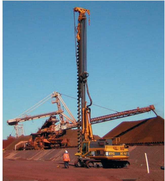
Vorbohren mit RG 16T und Endlosschnecke, Australien Predrilling with continuous flight auger on RG 16T, Australia
