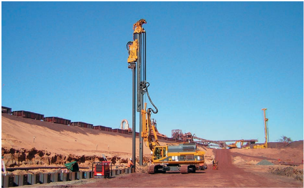
Spundwandeinbau mit RG 16T und Rüttler MR 100V-02 (oben in Garching, unten in Australien) Installation of sheet piles with RG 16T and vibrator MR 100V-02 (top: Garching, Germany, bottom: Australia)
