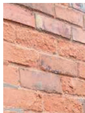
Spalling
