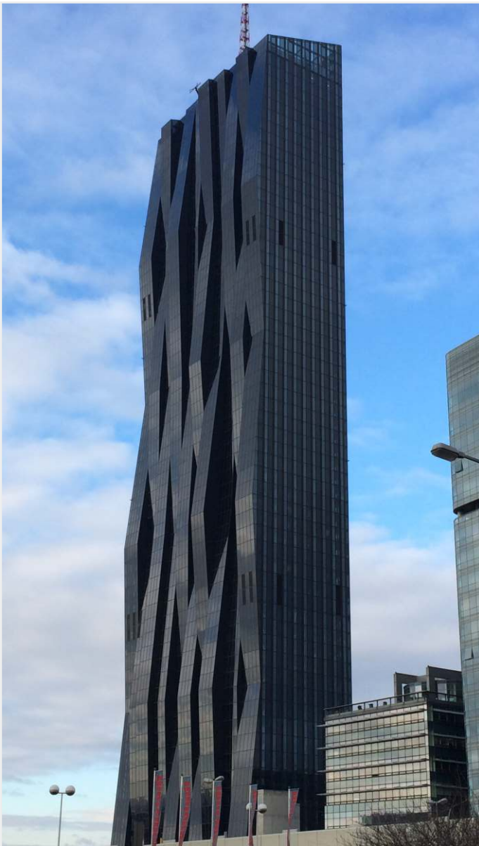
DC Towers (Wien, Austria)
