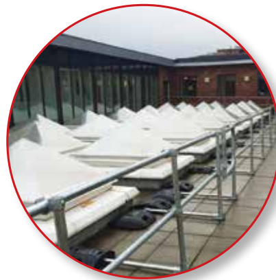
Roof Edge Protection
